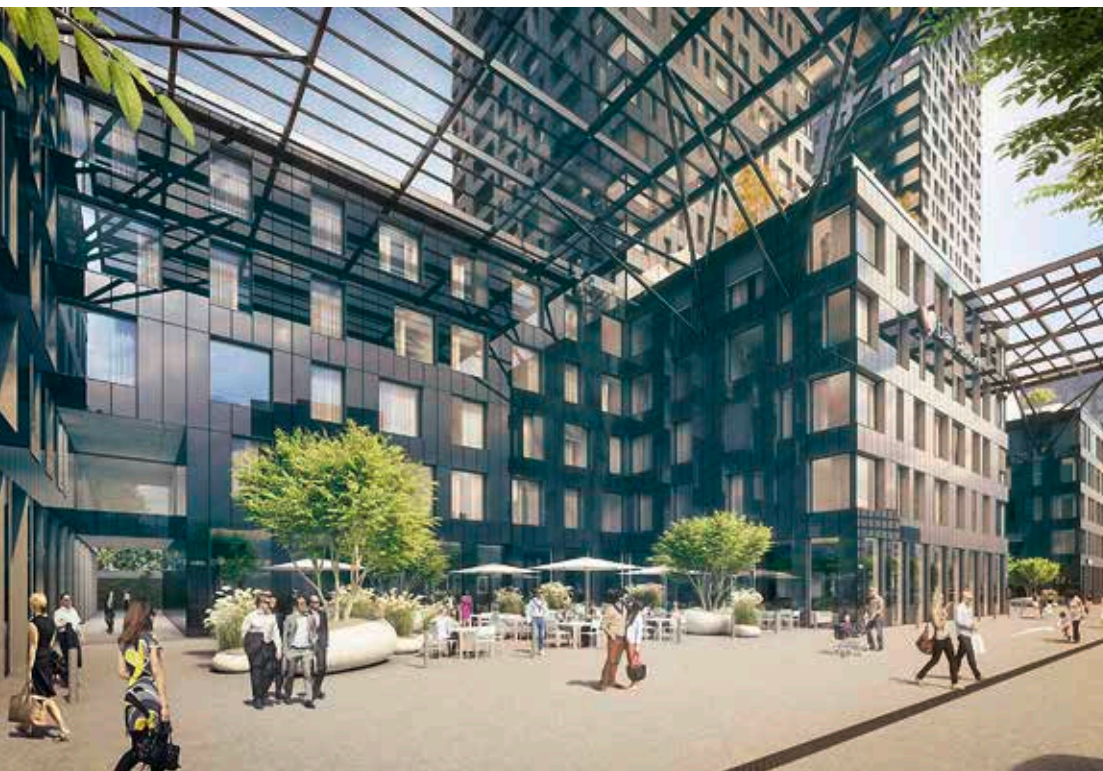
Das a-ja Resort in Zürich ist ein sogenanntes Minergie-Haus. Durch eine gut isolierte Gebäudehülle und eine automatische Belüftung mit Wärmerückgewinnung wird Energie eingespart.
